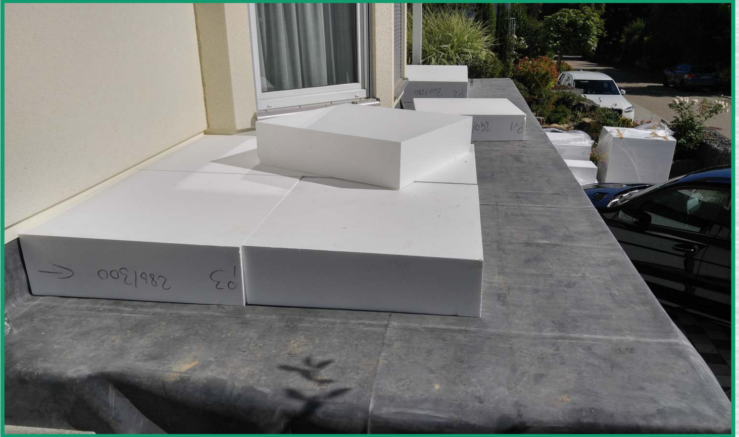
Wärmedämmung hier 30 cm
