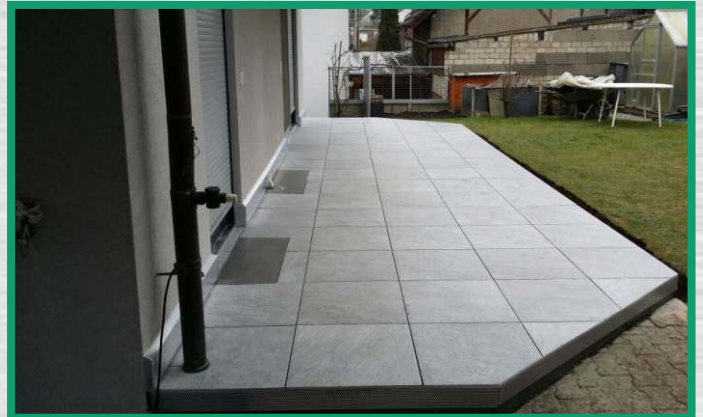
Abschrägung und Einarbeitung von Gitterrost
