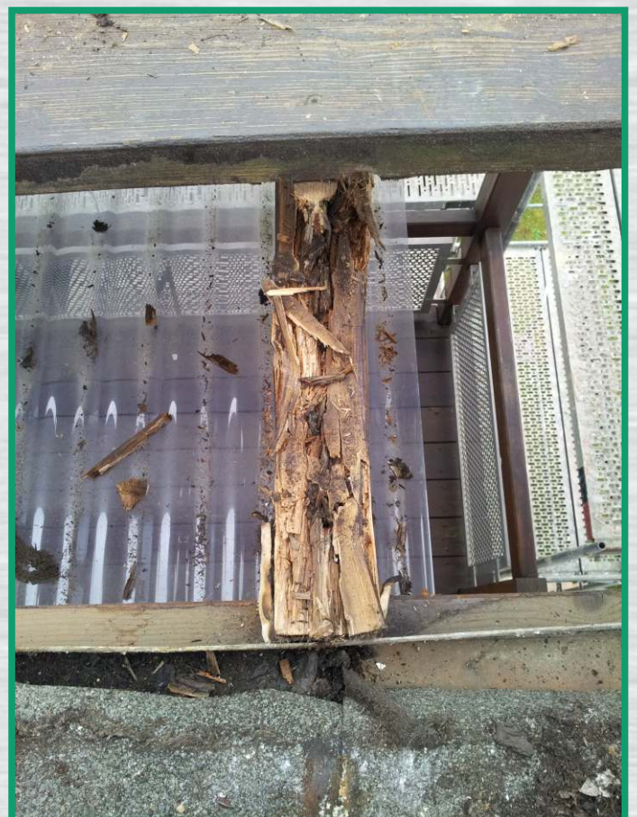
Verfaultes Holz unter den Trittböhlen
