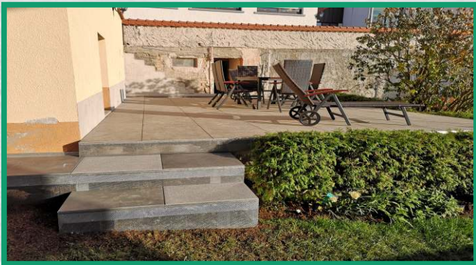
Treppenabgang von der Terrasse
