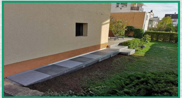
Weg seitlich vom Haus zur Terrasse
