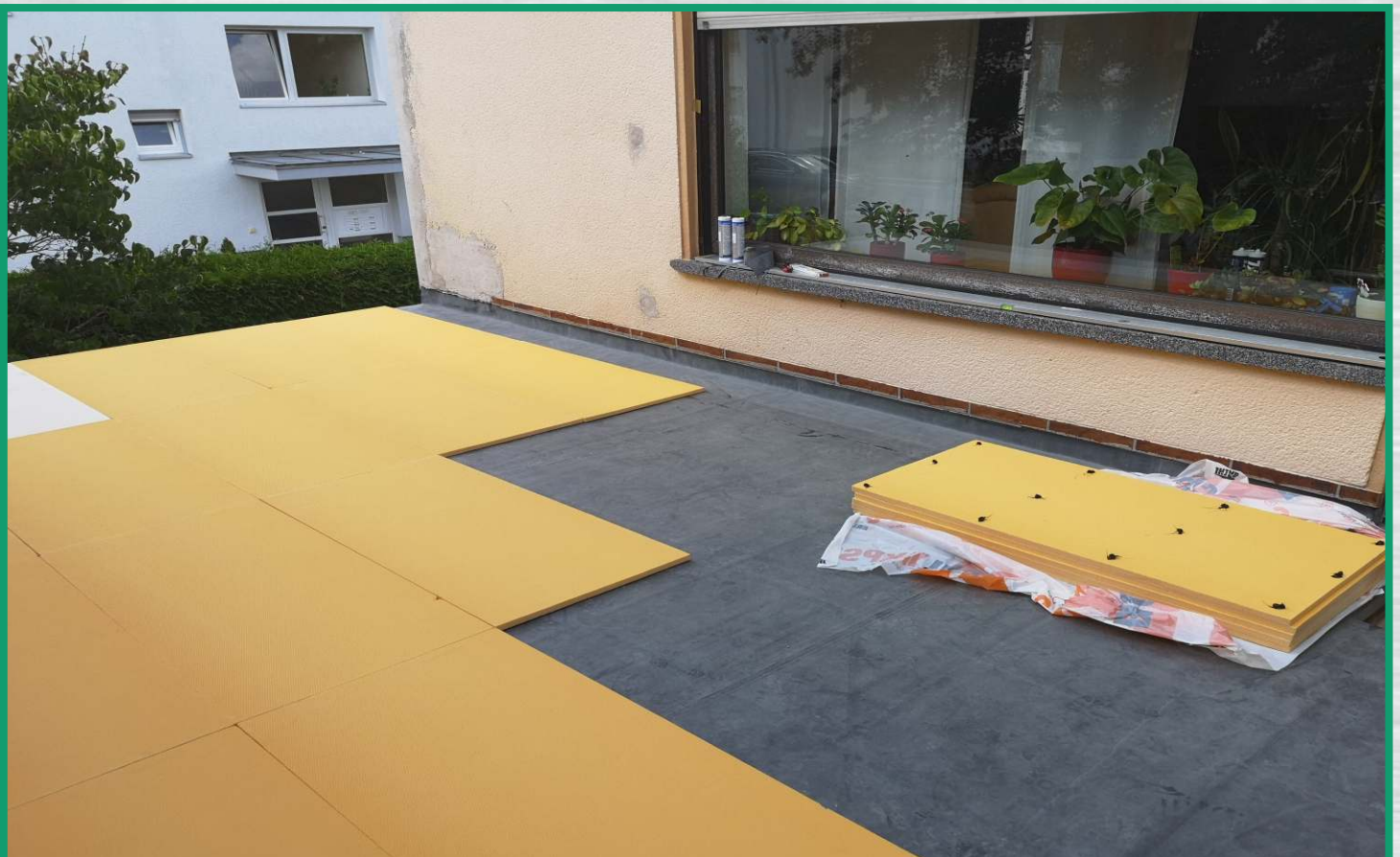
Dampfsperre und Wärmedämmung
