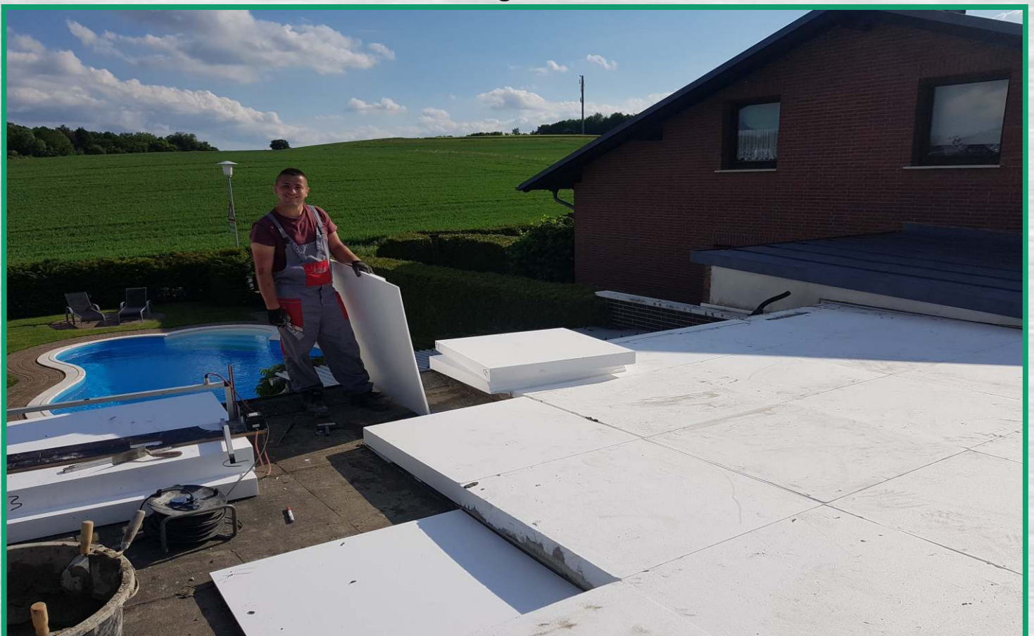
Flachdachsanierung mit Gefälle - EPS
