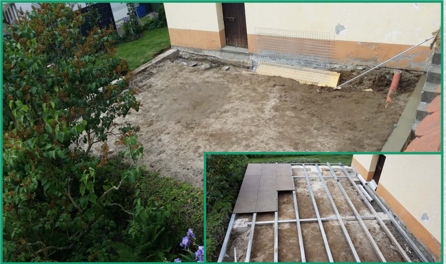
Terrasse alt - Nur Sand, Belag war Waschbetonplatte
