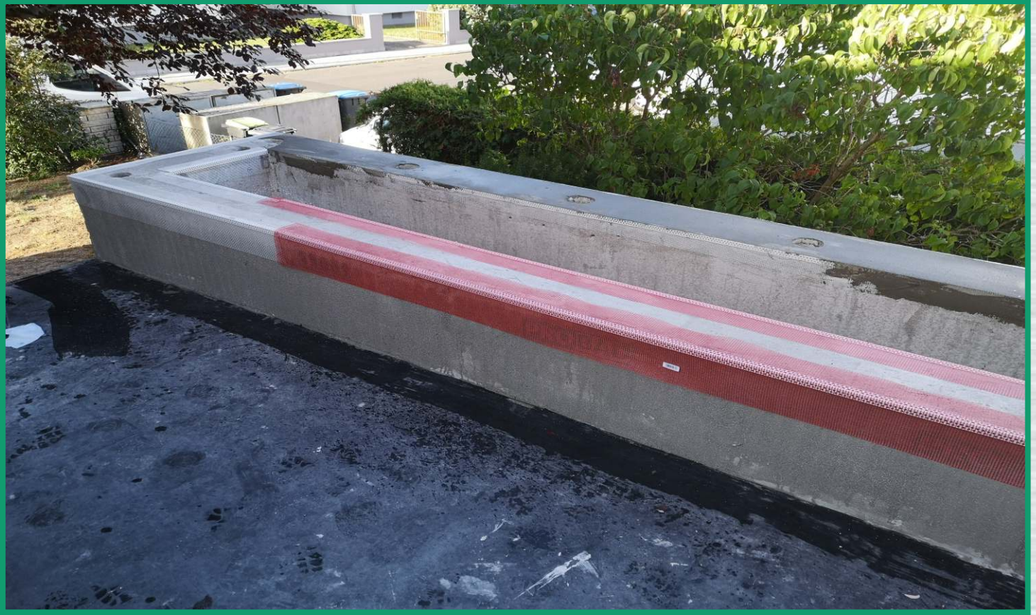
Blumenbeet wird verputzt
