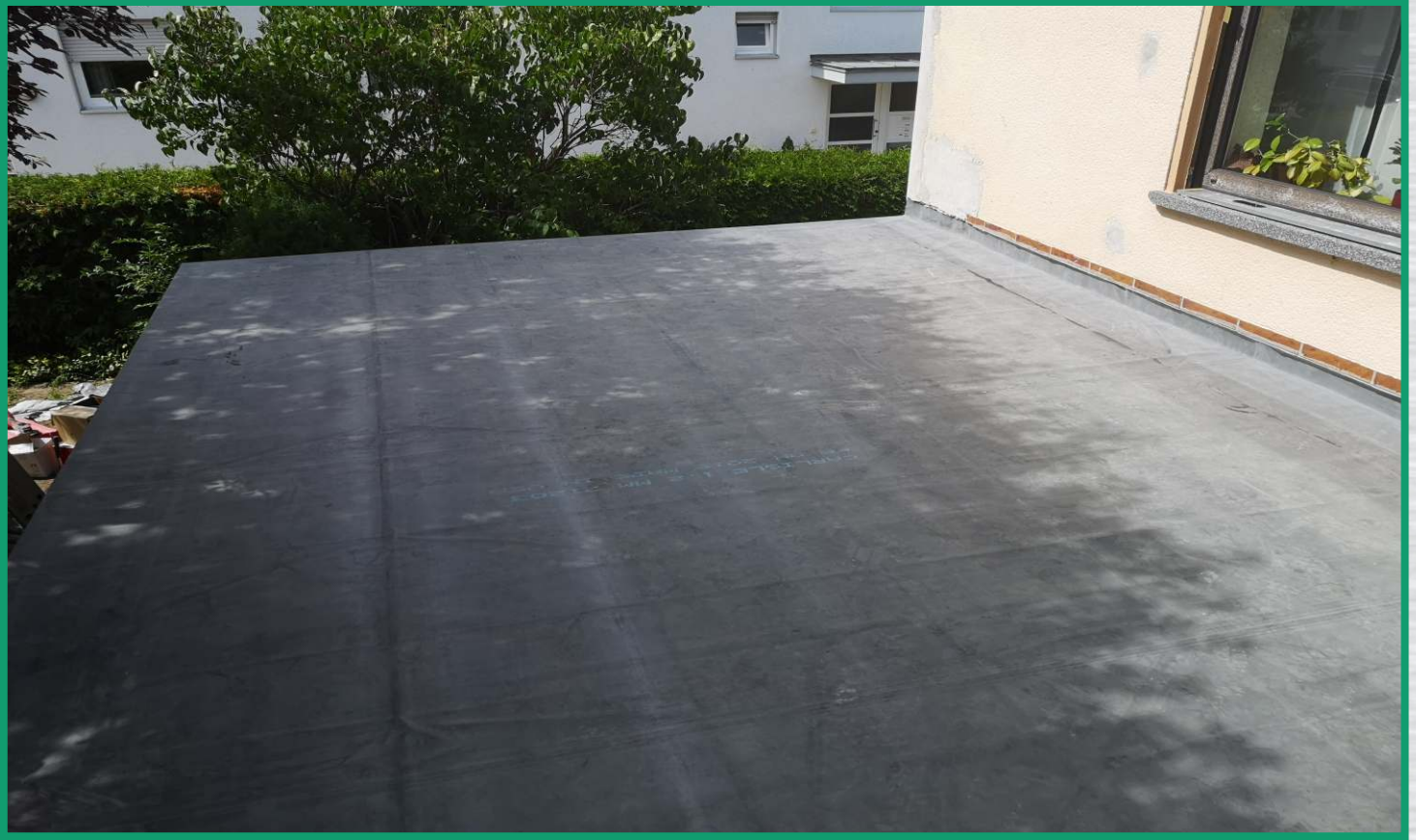
Die Abdichtungsebene mit BD - Folie an einem Stück
