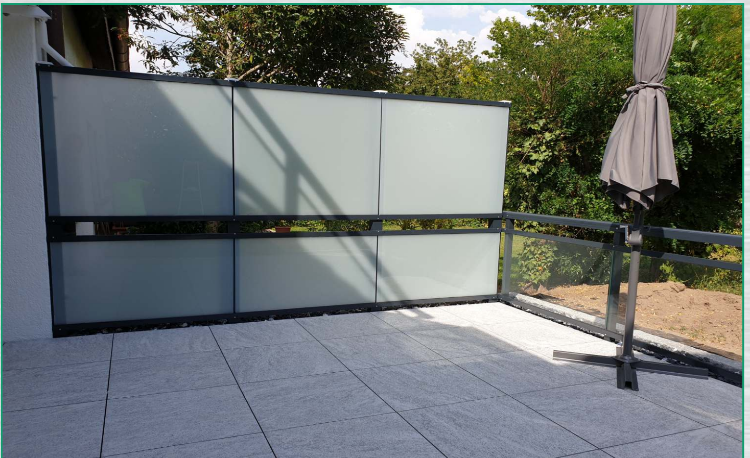
Terrasse mit Feinsteinzeug, Sichtschutz und Geländer
