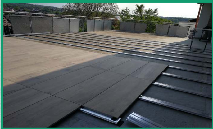
Während der Plattenverlegung
