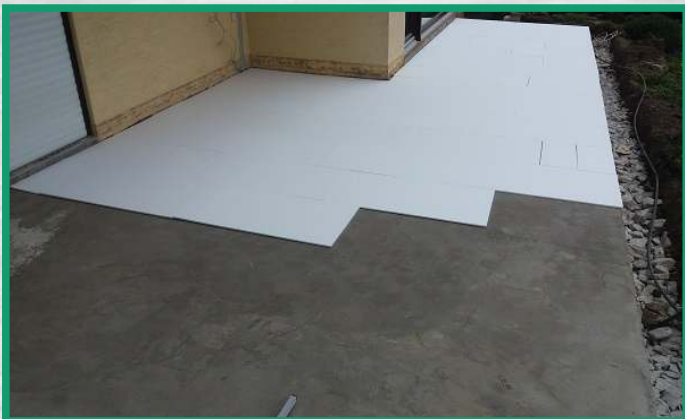
Fliesestrich wurde aufgebracht und Styropor
