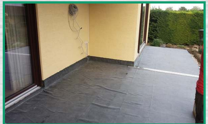
Abdichtung wurde verlegt
