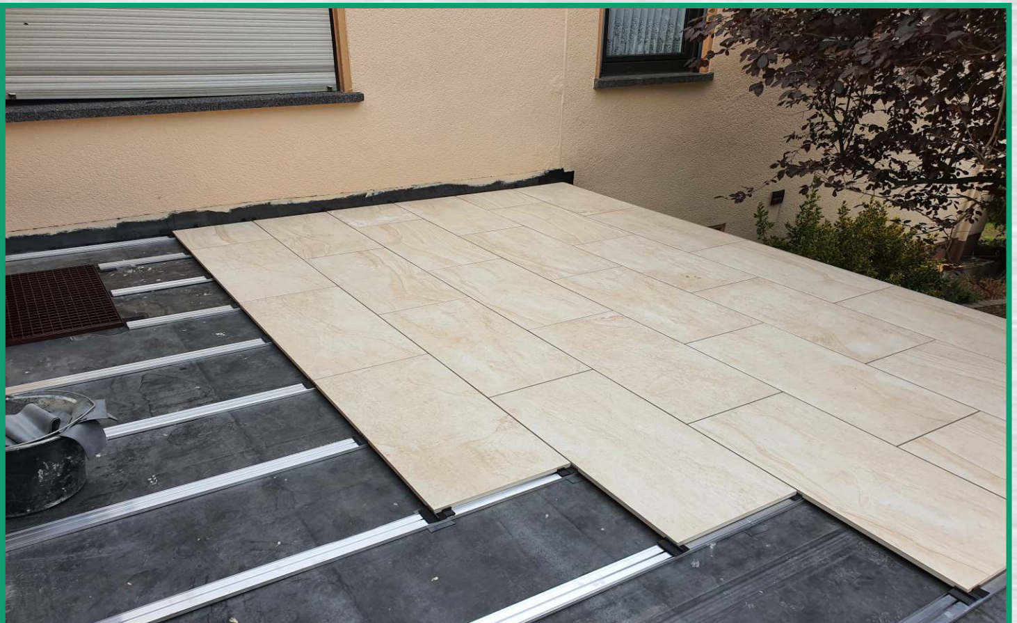
Verlegung der Fliesen auf BD - Drainage 80
