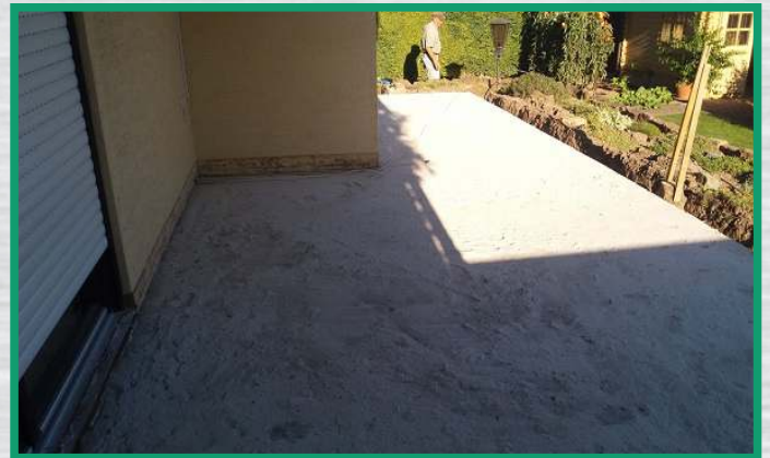
Nun ist die Betonplatte freigelegt
