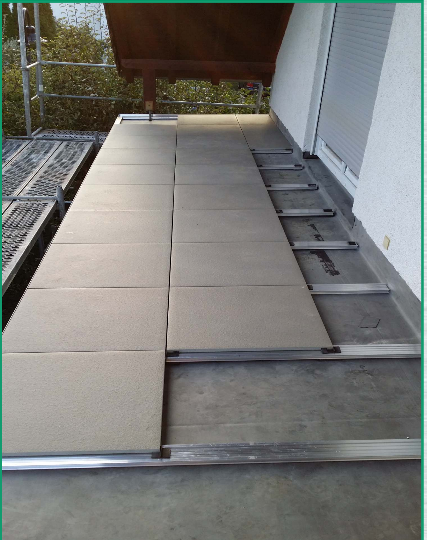
BD - Drainagesystem 80 und Bella - Terrazza - Ceramics
