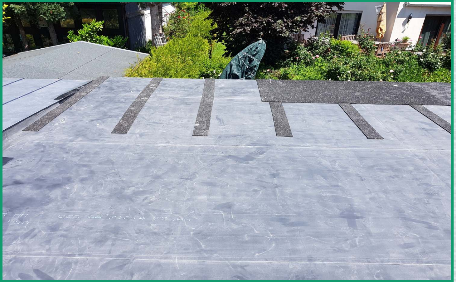
Flachdachsanierung mit Gefälle - EPS
