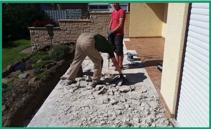
Abtragen von Fliese und Estrich
