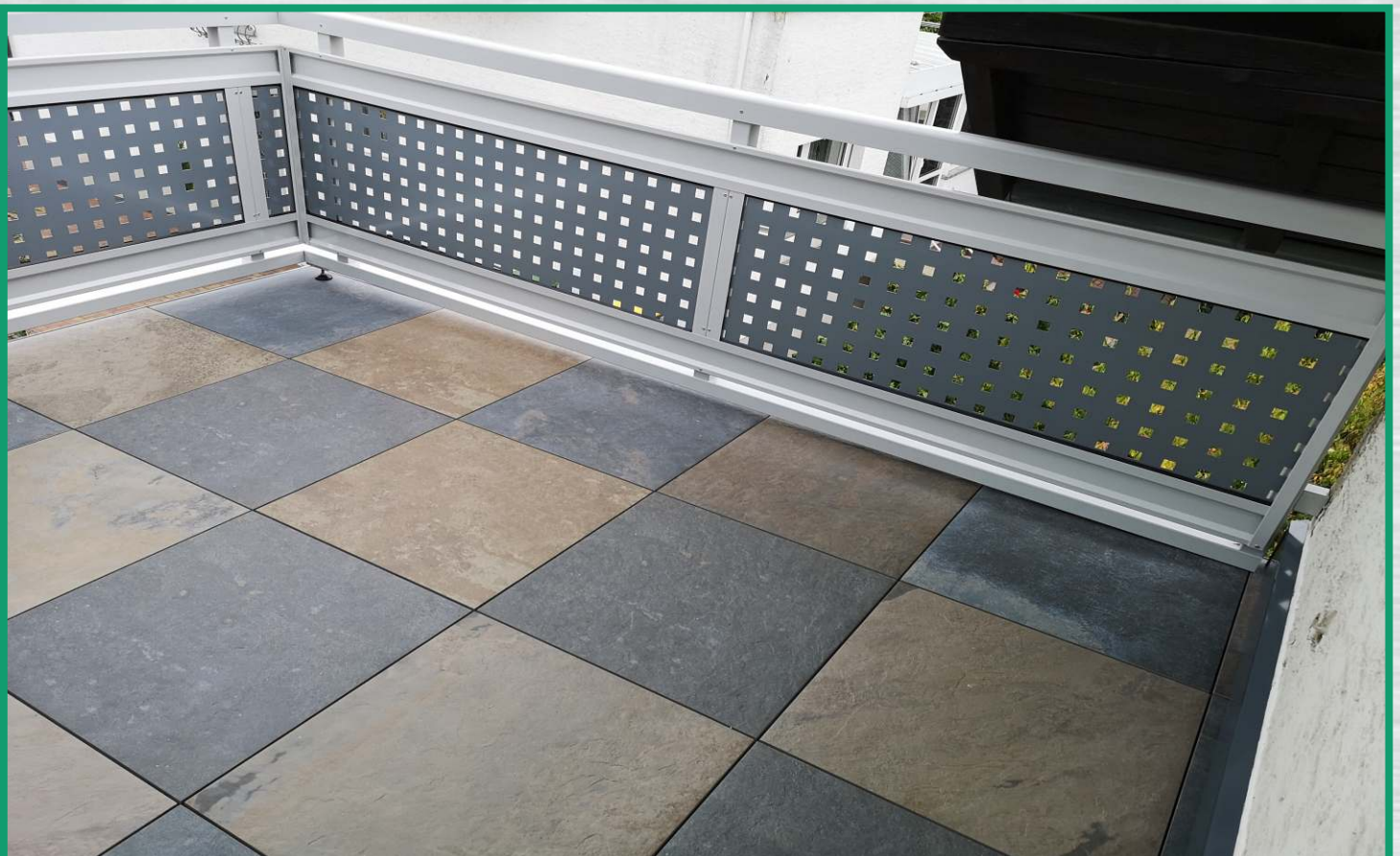
Neu sanierter Balkon mit LS - Geländer
