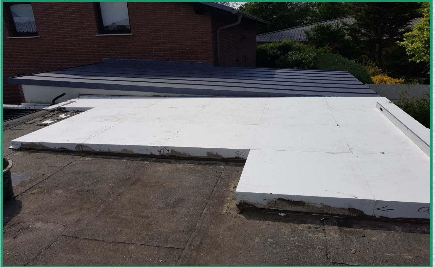
Flachdachsanierung mit Gefälle - EPS
